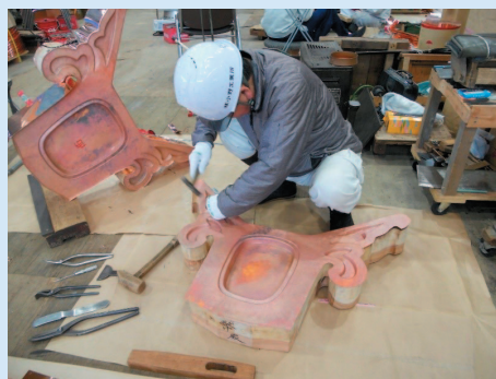
写真 2：木下地に合わせ鬼を打ち出している様子
