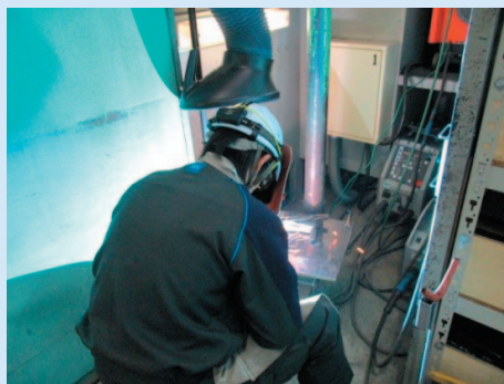
写真：アーク溶接作業の様子
