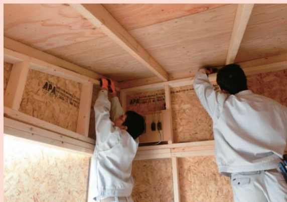
写真：電気科による配線工事の様子 (新潟県立新潟工業高等学校)
