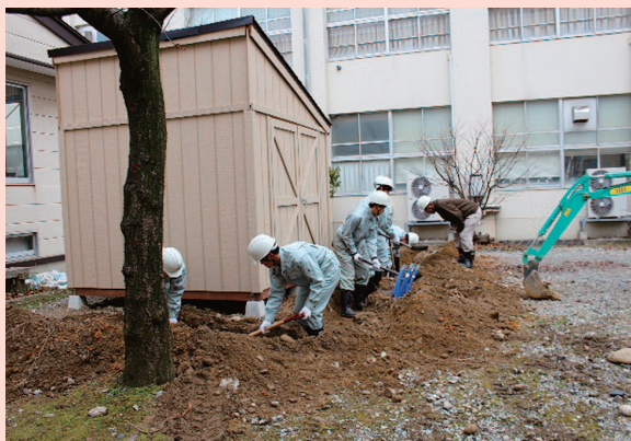
写真：土木科による地中埋設配管の様子 (新潟県立新潟工業高等学校)
