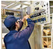
写真：作業の様子
