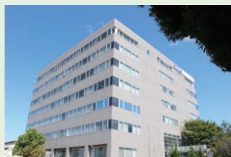
写真：関西本社建屋
