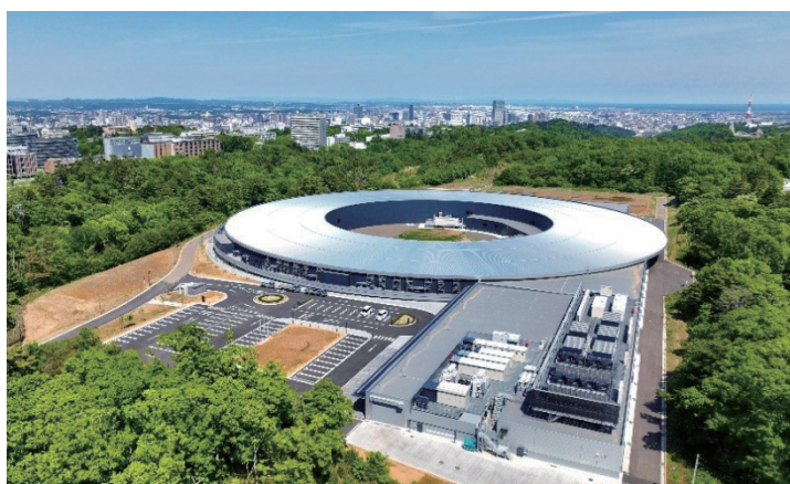
写真：3GeV 高輝度放射光施設（NanoTerasu）の全景 （（国研）量子科学技術研究開発機構（QST）提供）
