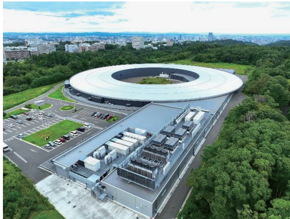
図331-2：3GeV高輝度放射光施設（NanoTerasu）の全景
