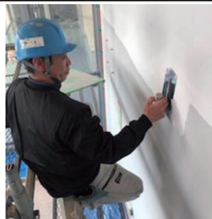
図2：漆喰塗り作業
