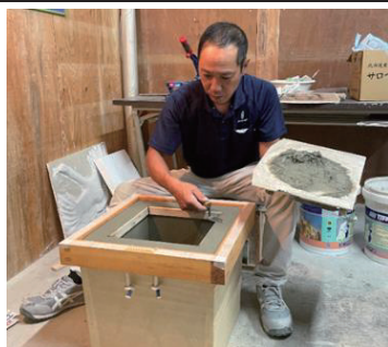
図1：鏝（こて）を使って整える作業
