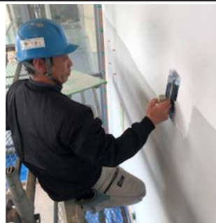
図2：漆喰塗り作業
