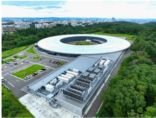
図331-2：3GeV高輝度放射光施設（NanoTerasu）の全景
