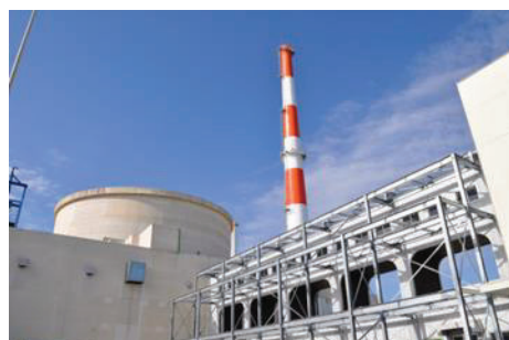
高速実験炉「常陽」
