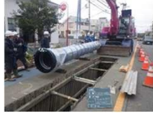
老朽管路の改修
