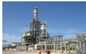
ポリエチレンプラント
