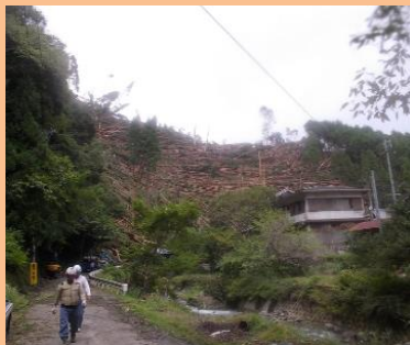
←関西電力管内の被害状況
