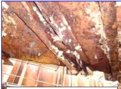
煙道(底板)外部腐食状況
