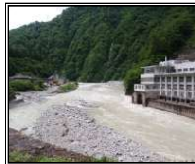
出水による放水口土砂堆積 (富山県)
