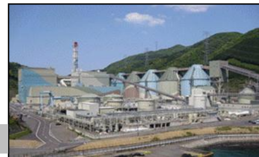
新設・既設火力発電所
