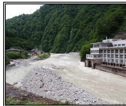
出水による放水口土砂堆積 (富山県)
