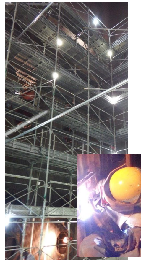
【復旧作業状況】
