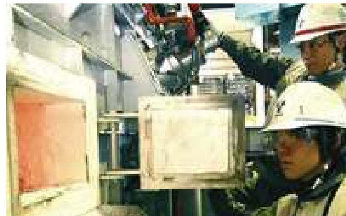
お客さま設備の改造・調整作業
