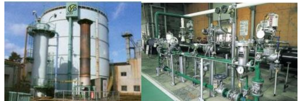
長岡中央浄化センター ガスタンク
