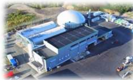
メタン発酵施設
