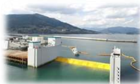
フラップゲート式水害防止装置
