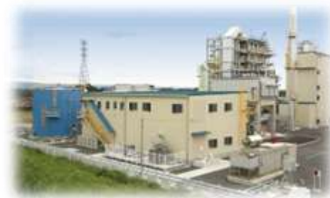
汚泥再生処理施設
