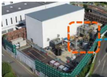
実証試験設備
