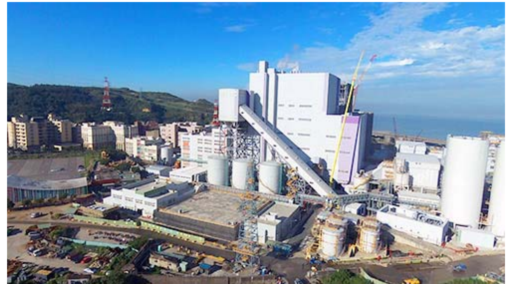
台湾電力の林口火力発電所
