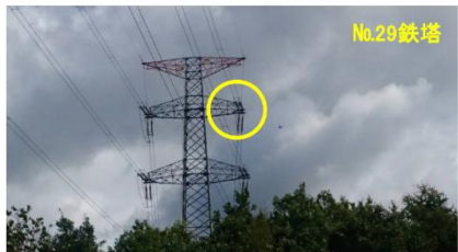
地震の揺れにより①ジャンパー線が②鉄塔に接触
