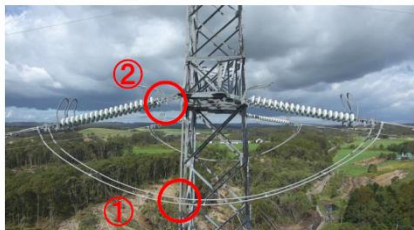
地震の揺れにより①ジャンパー線が②鉄塔に接触
