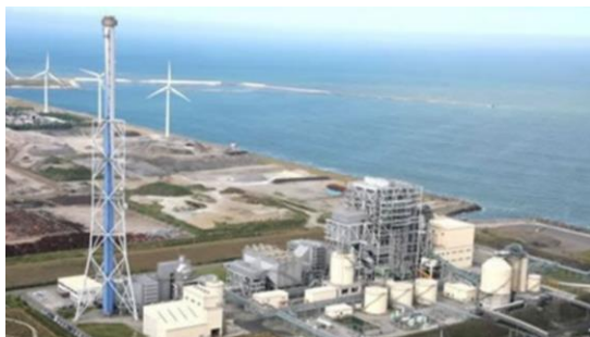
日本製鉄 鹿島火力発電所 外観
