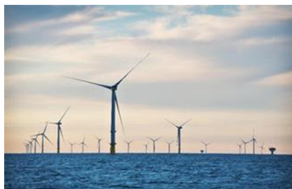
図.トライトン・ノール洋上風力発電所 (出典：電源開発ホームページ)
