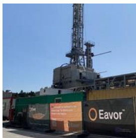
図.ゲーレッツリート地熱発電・地域熱供給プロジェクト（出展：中部電力ホームページ）
