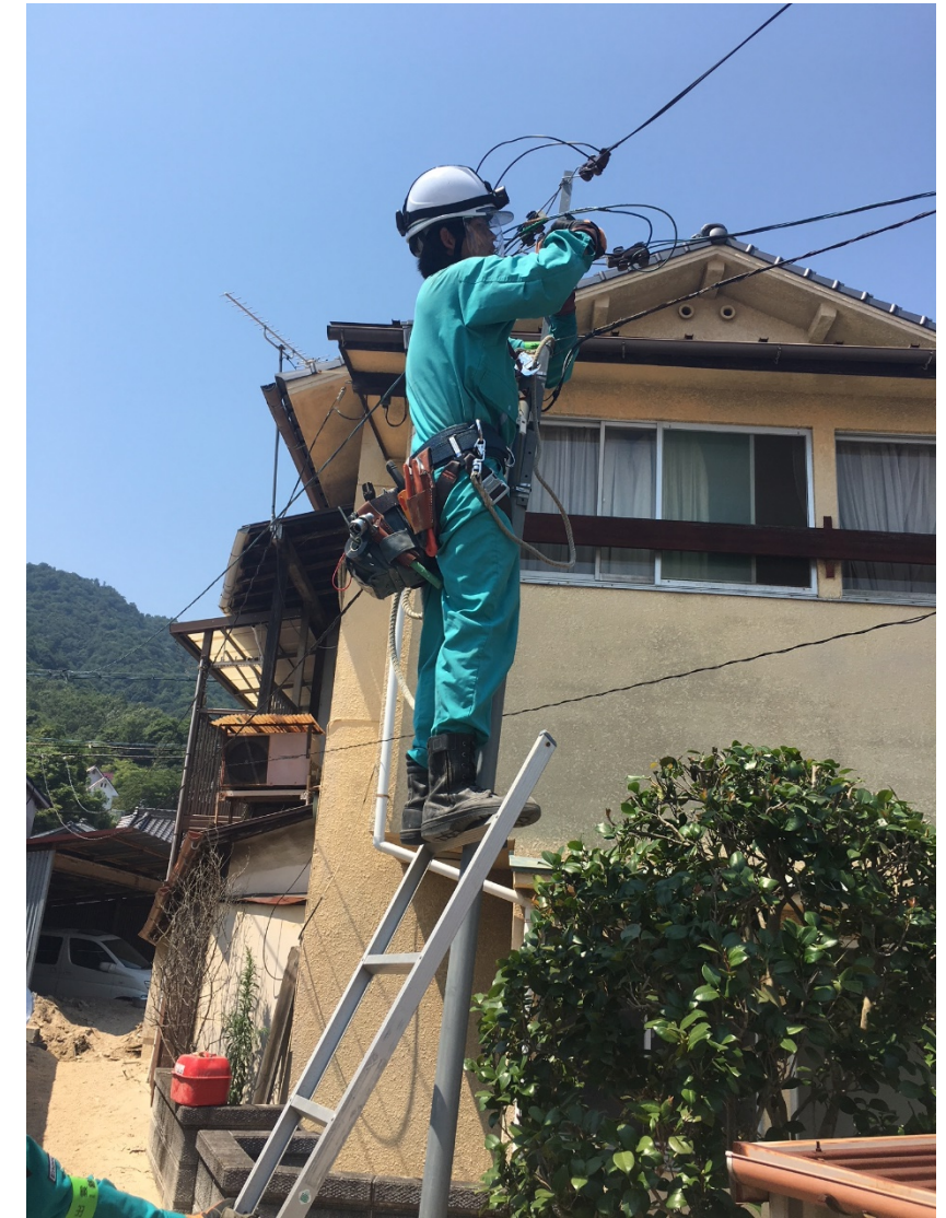
中国電力社員による復旧作業
