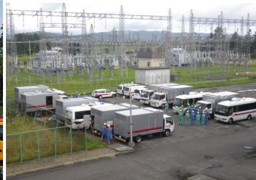
西滝川変電所で待機中の四国電力発電機車
