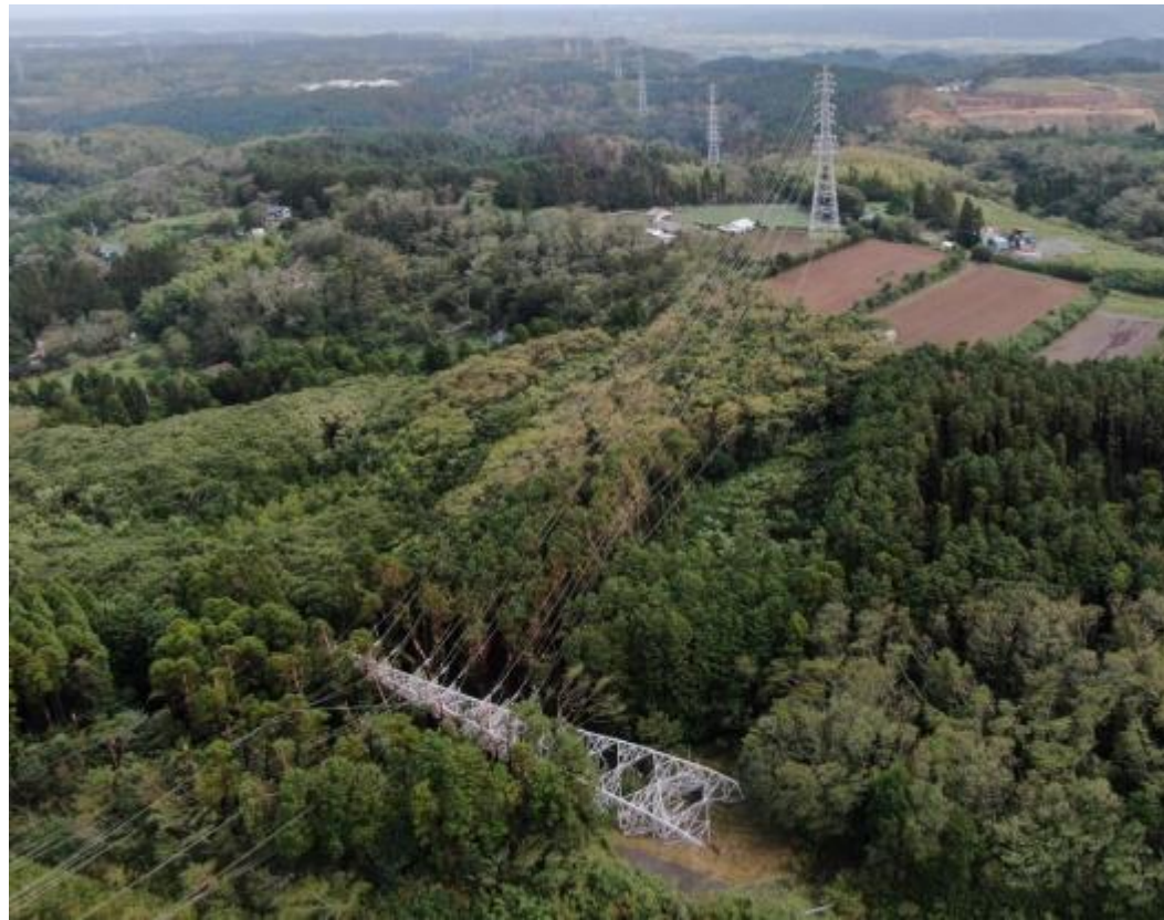
鉄塔設備の倒壊（君津市）
