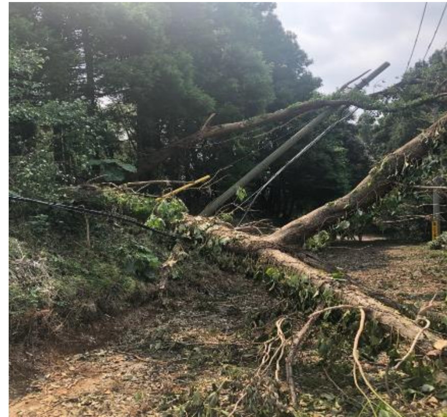
倒木による電柱倒壊（四街道市）
