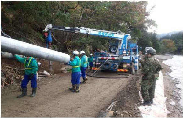
＜仮設道路での配電線復旧作業の状況＞
