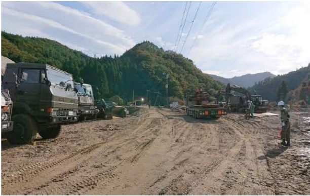
＜自衛隊による仮設道路設置作業の状況＞
