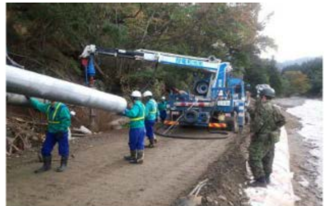
【図 45】自衛隊による仮設道路作業の状況と仮設道路での配電線復旧作業の状況
