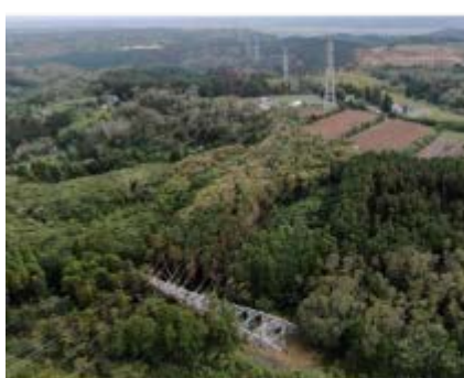
鉄塔倒壊現場（君津市）
