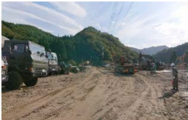
【図 45】自衛隊による仮設道路作業の状況と仮設道路での配電線復旧作業の状況
