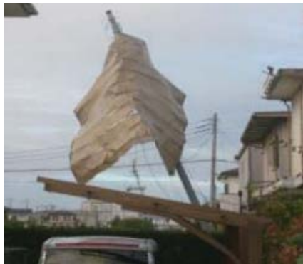
<飛来物による電柱倒壊（東金市）>
