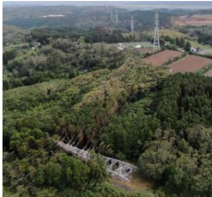
<鉄塔の倒壊（君津市）>
