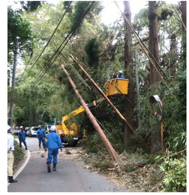
+ 高所作業車、技術者
