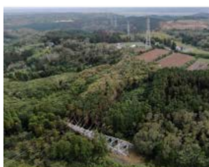
鉄塔倒壊現場（君津市）
