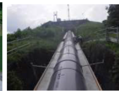
水圧鉄管(工事中)
