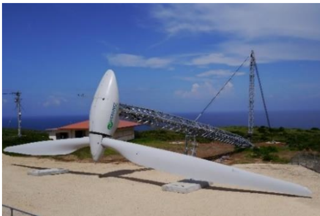
▲ 栗国可倒式風力設備・傾倒時
