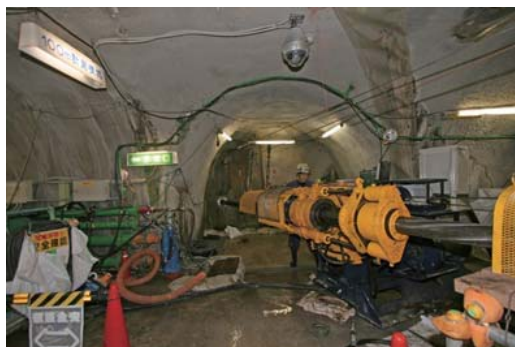
【坑内ボーリング調査】
