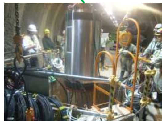
第3段階における調査研究の例 (幌延：人工バリア性能確認試験の様子)
