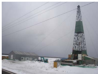
調査現場の外観
