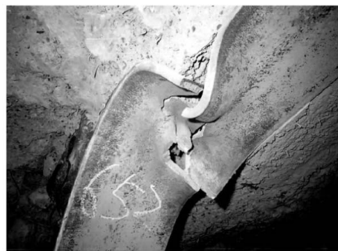
写真-1 上半支保工の肩部 (165km230m 付近)
