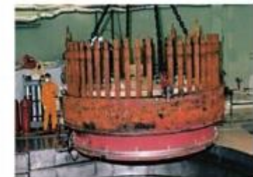
設備解体 （原子力発電所）
