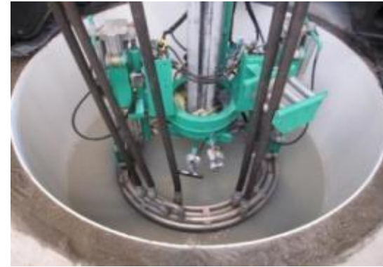
緩衝材除去状況
