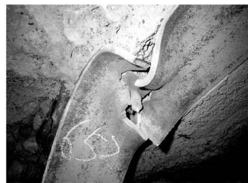
写真-1 上半支保工の肩部 (165km230m 付近)
