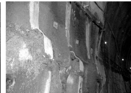
写真-2 上半支保工の根足部 (166km960m 付近)
