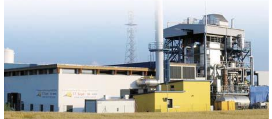
木材ガス化プラント
