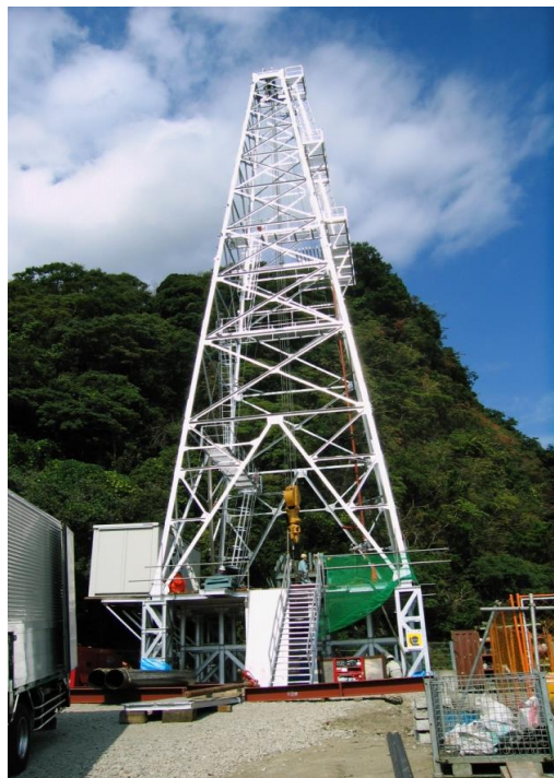
ボーリング調査の外観（やぐら）
