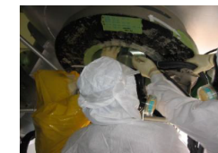
補修作業訓練 炉内構造物取替工法訓練
