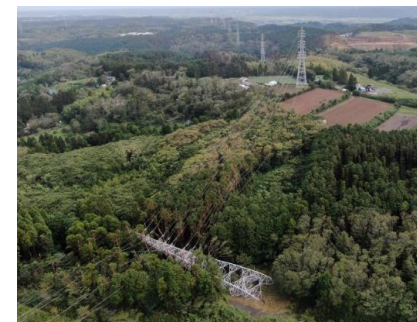
鉄塔設備の倒壊（君津市）
