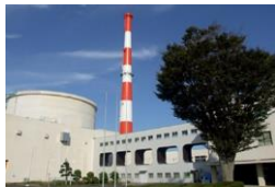
高速実験炉「常陽」
