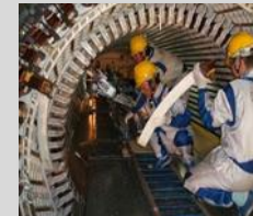
発電機補修工事
