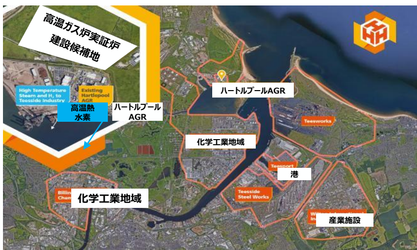
英国高温ガス炉実証炉 建設候補地 （イングランド北東部ダラム州ハートルプール。ティーズ川の河口の北岸に位置し、英国原子力規制室（ONR）の認可が得られたサイトのひとつ） EDF-Energy パンフレットより
