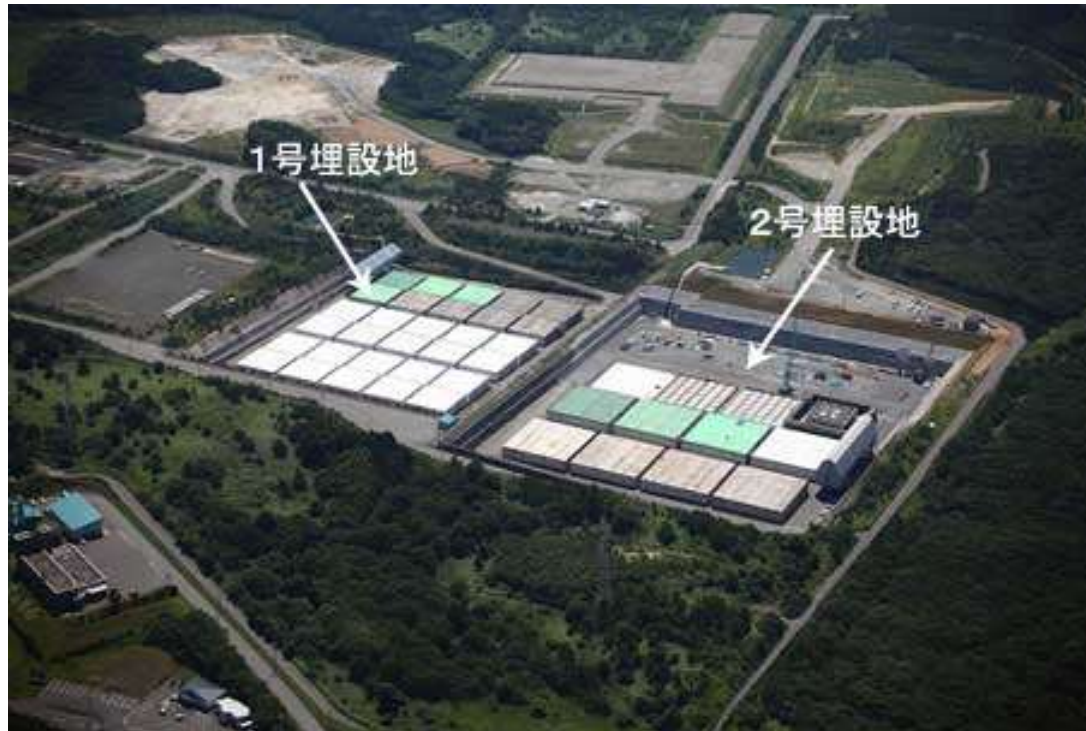
低レベル放射性廃棄物埋設センターの外観
