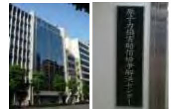
センター(東京事務所)外観
