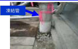
(陸側遮水壁 試験凍結箇所例)
