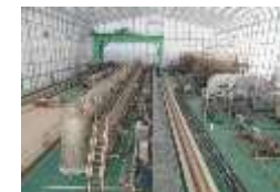
(高性能多核種除去設備)
